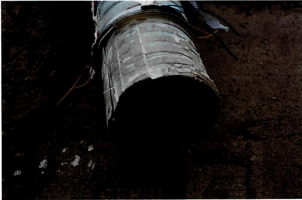
照片二：110kV 变电构架复合横梁单跨结构中导线右侧横梁法兰与复合横担连接处开裂破坏情况
